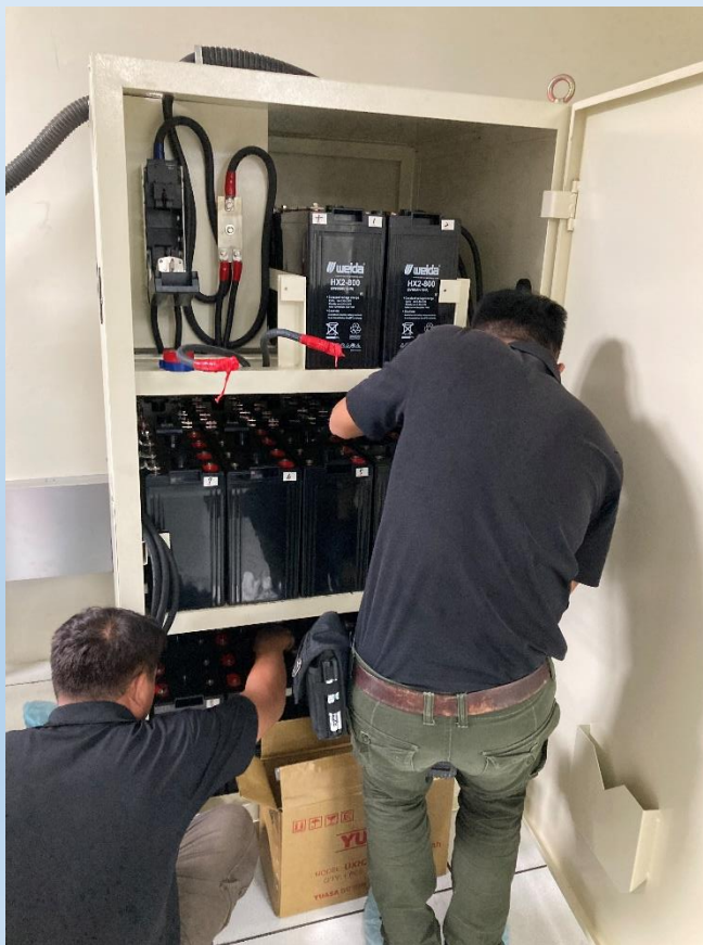
拆除舊電池組
