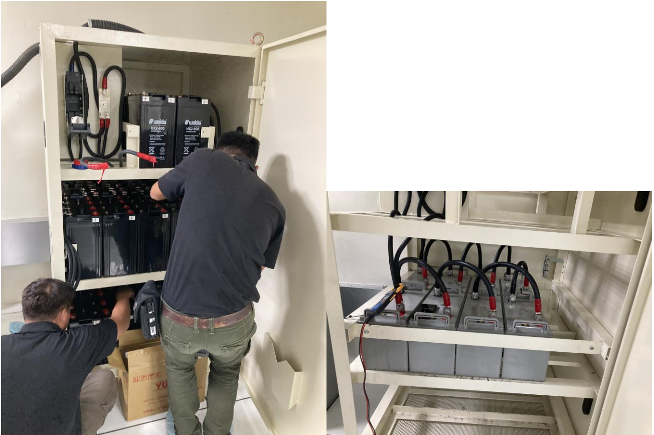
電池組更換工程照片
